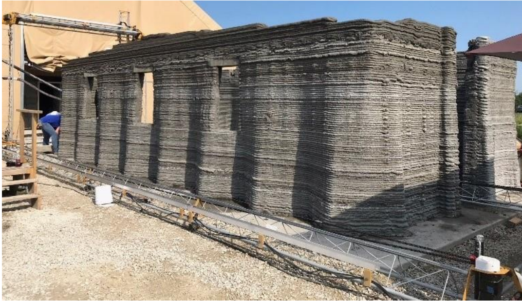
Figura 20 – Imprimarea 3D a unei clădiri
